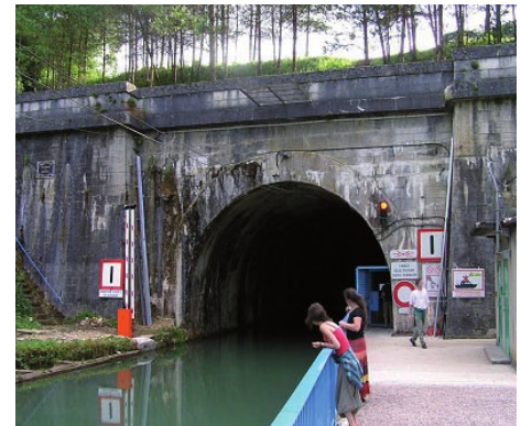
Tunnel de Mauvage
