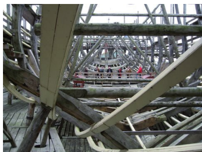
De Zeven Provinciën in aanbouw
