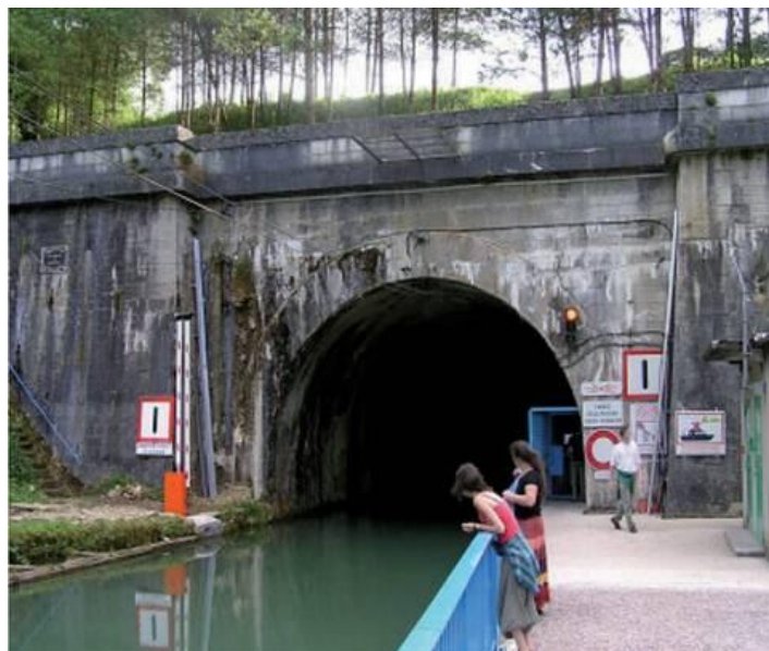
Tunnel de Mauvage
