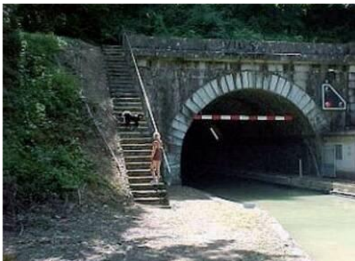
Tunnel de Mont-Billy
